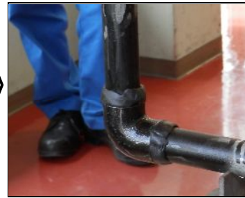
SMを凹凸部に充填します。
