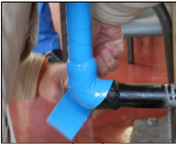
K450をハーブラップで巻き付けます。(R部は厚みが出ます)
