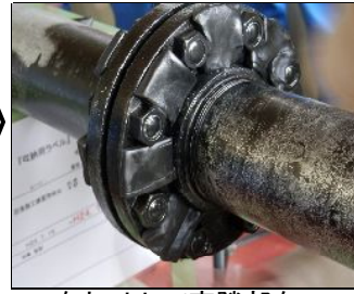
SMをカットして空隙部を充填します
