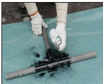
プライマーNo.10を塗布します。
