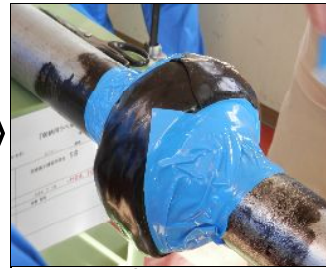
K-450(幅広)を巻き付けます側面部
