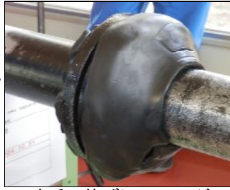
SMを手で伸ばしてフランジ全を包み込むように巻き付けます
