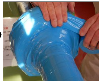
側面部はテープを引張り、角度をつけながら巻き付けていきます
