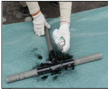
プライマーNo.10を塗布します。
