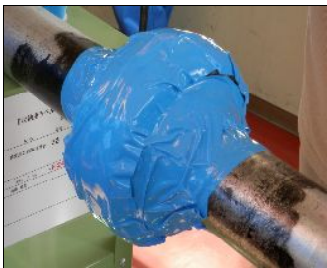
K-450(幅広)を巻き付けます中央部
