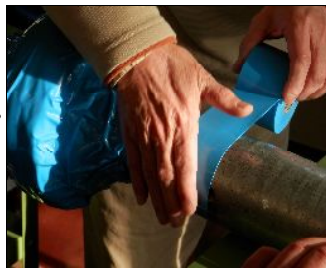
直管部より中央へ向けてK-450を巻き付けます
