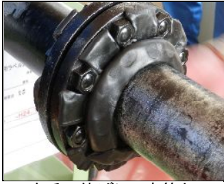
SMを手で伸ばして直管との接続部を充填します
