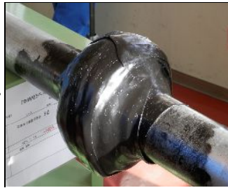
ST施工完了
